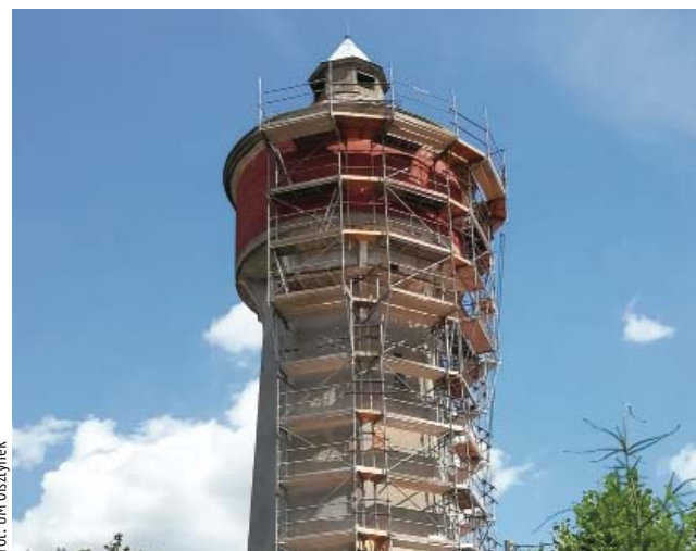
Wkrótce zakończą się prace przy wieży ciśnień w Olsztyńku
